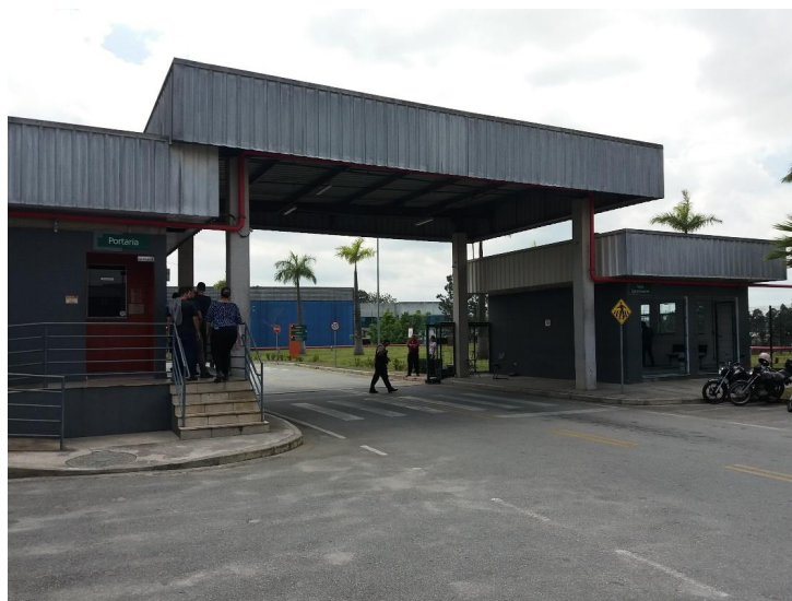
Portaria de acesso
