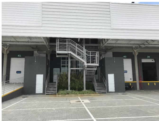
Fachada do galpão
