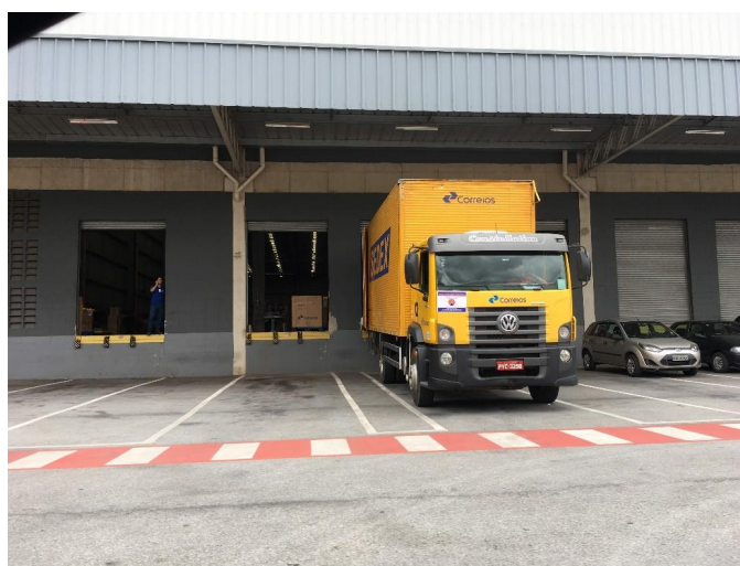
Área de galpão e marquise
