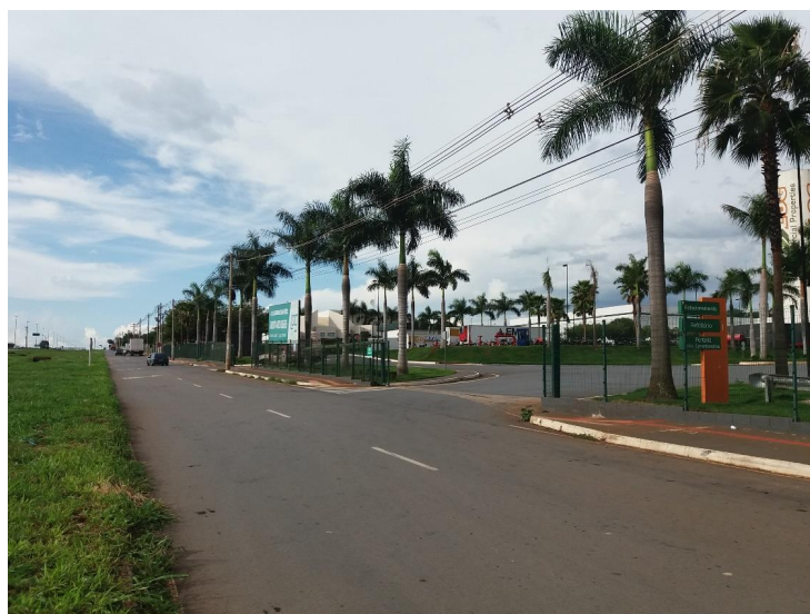
Rodovia BR-153, com o imóvel à direita
