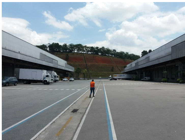
Vista geral do imóvel
