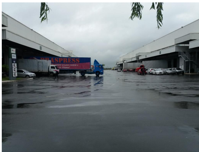
Área de manobra e docas do imóvel
