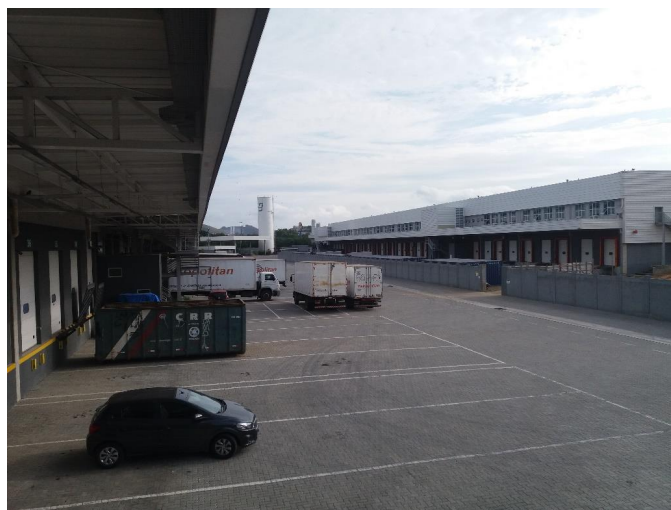
Área de galpão e marquise
