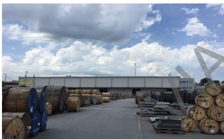
1 Locação de 7.476,58 m 2 de área de galpão e 10.605,17 m 2 de área de pátio
