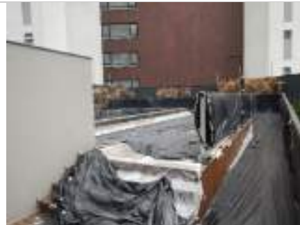
Piscina (em construção)
