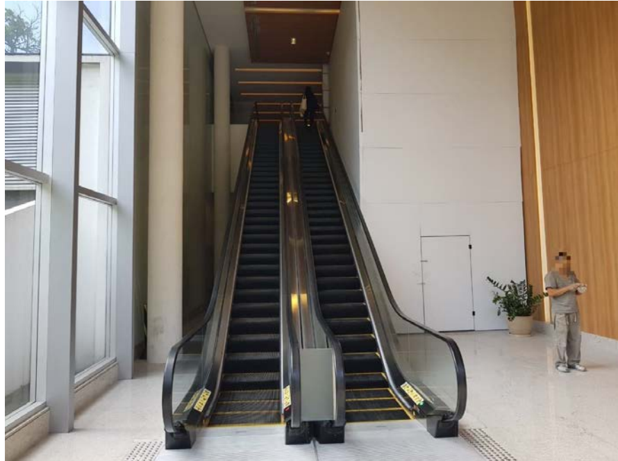
ESCADAS DE ACESSO À RECEPÇÃO
