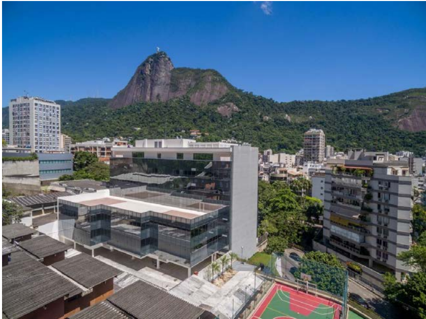
VISTA AÉREA DO EDIFÍCIO
