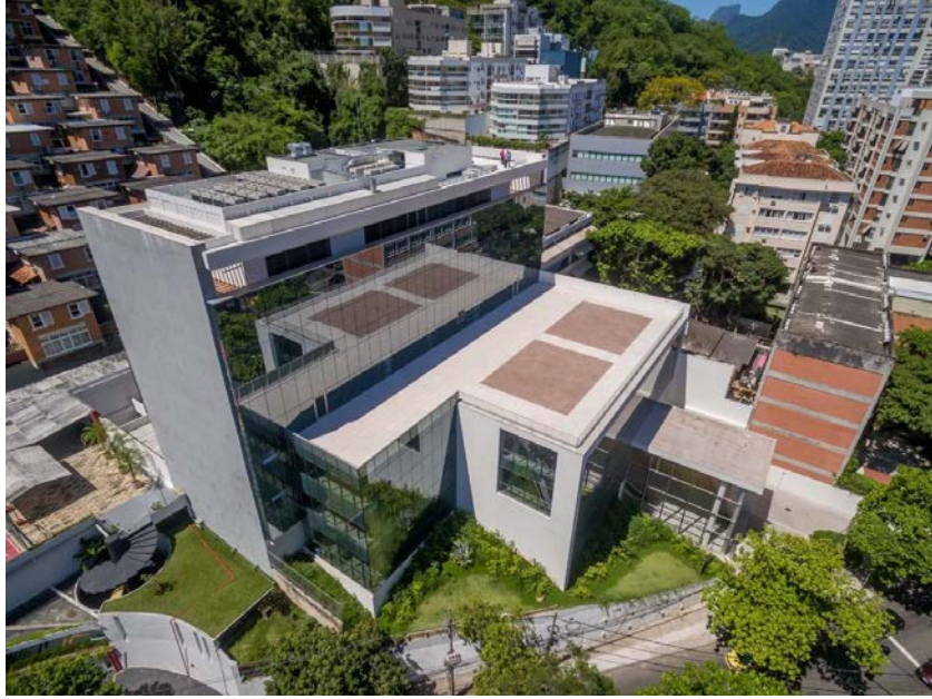
VISTA AÉREA DO EDIFÍCIO
