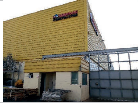
Vista parcial da fachada
