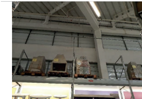
Detalhes da estrutura em pré-moldado
