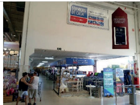
Detalhe da estrutura do mezanino
