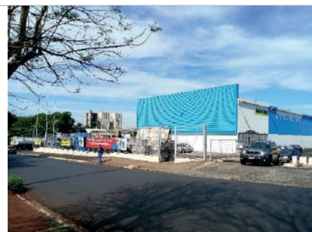
Acesso pela R. Rodrigues Alves
