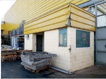
Banheiro e depósito
