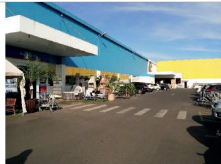
Vista Parcial da fachada do estacionamento
