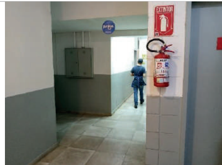
Hall de acesso do mezanino para vestiários e refeitório
