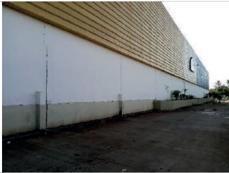
Fachada da Av. Fábio Barreto
