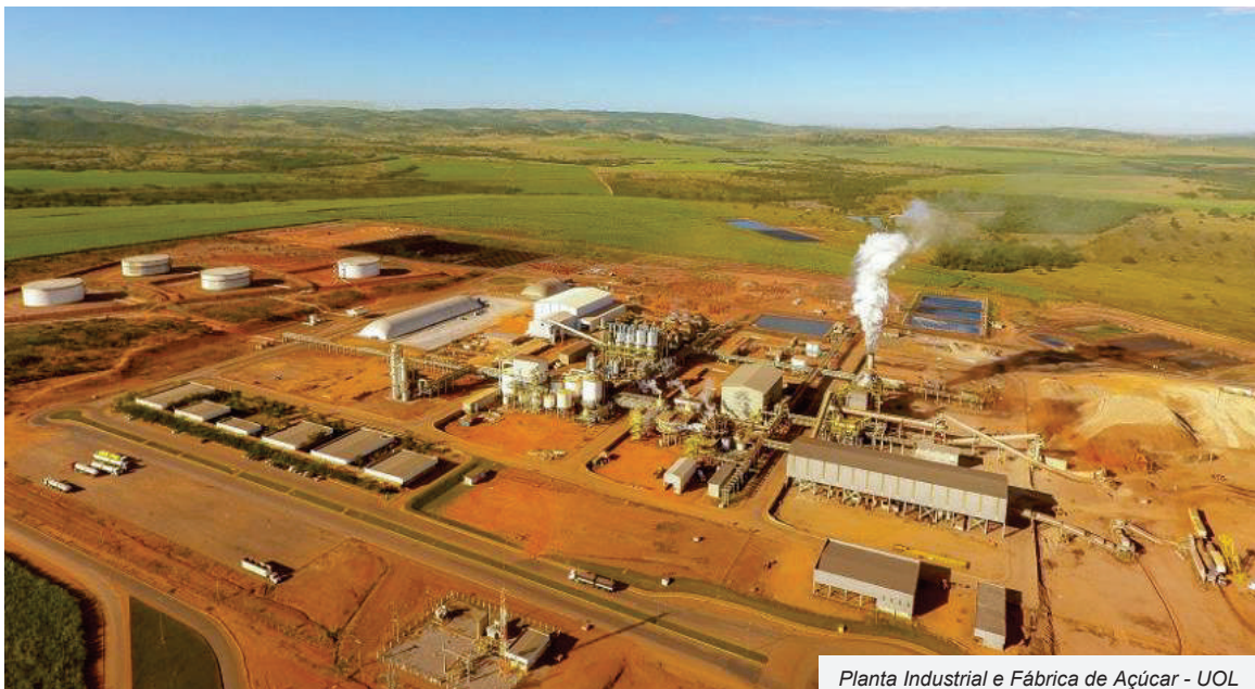
Planta Industrial e Fábrica de Açúcar - UOL
