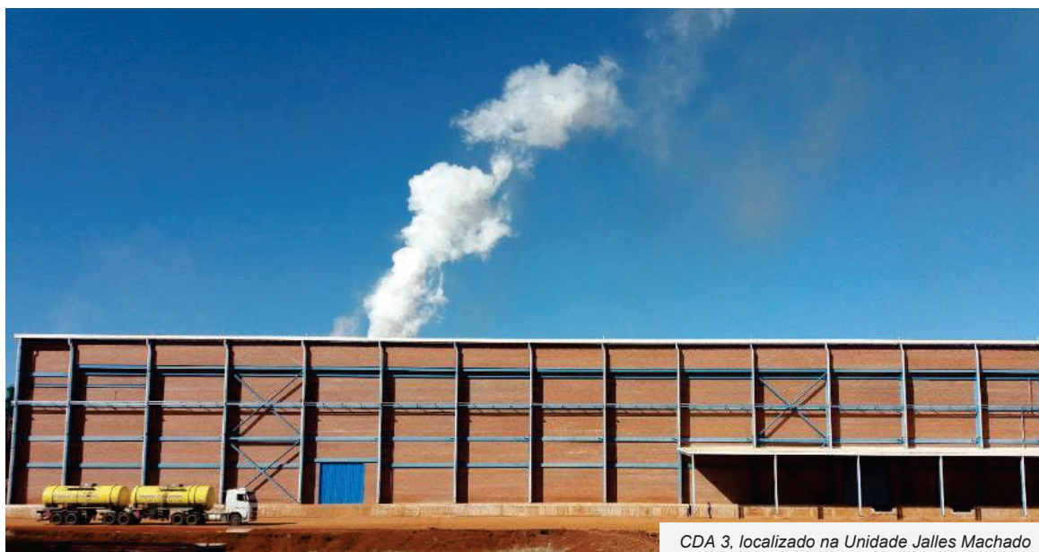
CDA 3, localizado na Unidade Jalles Machado
