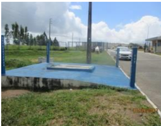
POÇO DE INSPEÇÃO DO GASODULTO
