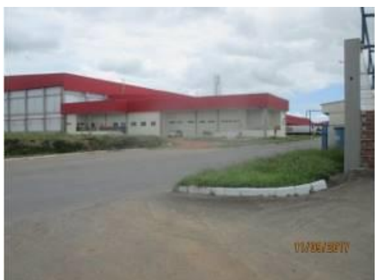
FACHADA DOS FUNDOS - PRÉDIO DO CD
