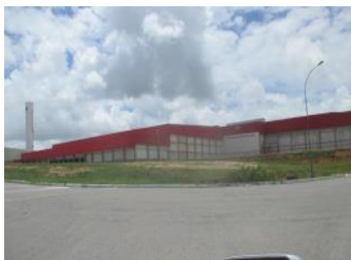
FACHADA FRONTAL - PRÉDIO DO CD
