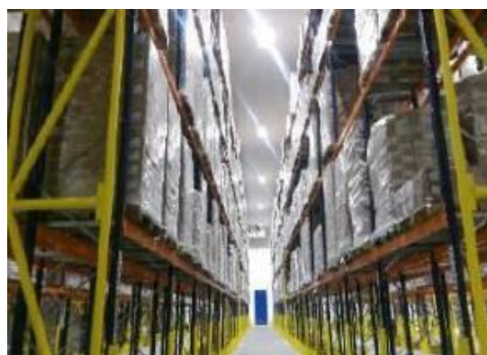
ASPECTOS INTERNOS – CÂMARA FRIA
