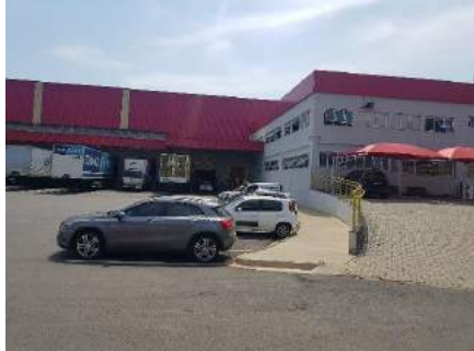
Vista externa do Bloco II
