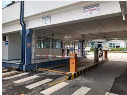
Guarita de controle de acesso
