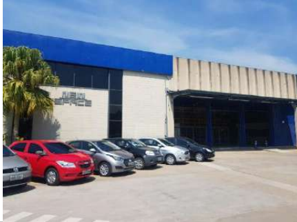
Acesso ao Galpão
