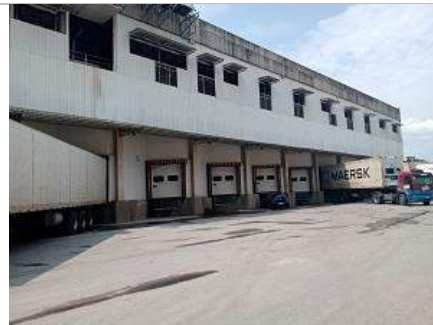
Fachada Galpões C6 e C7
