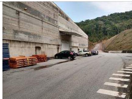
Fachada Lateral Galpão C
