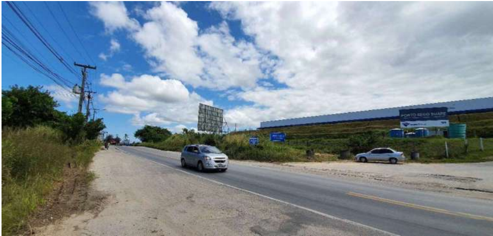
Vista da via de acesso com o imóvel a direita
