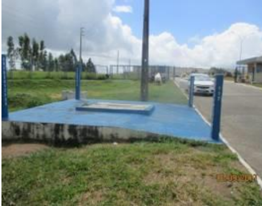
POÇO DE INSPEÇÃO DO GASODULTO
