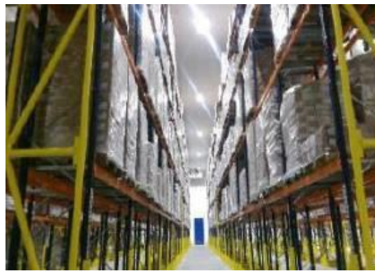
ASPECTOS INTERNOS – CÂMARA FRIA
