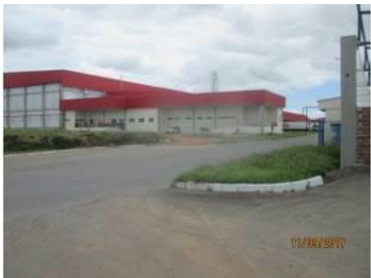
FACHADA DOS FUNDOS - PRÉDIO DO CD
