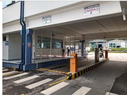
Guarita de controle de acesso
