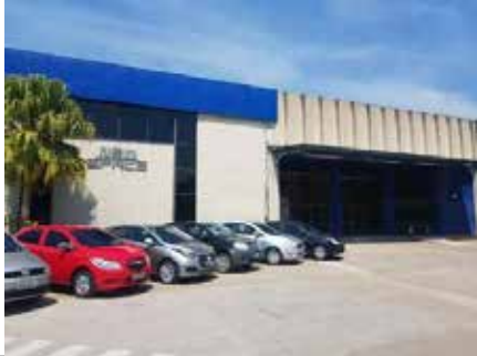
Acesso ao Galpão
