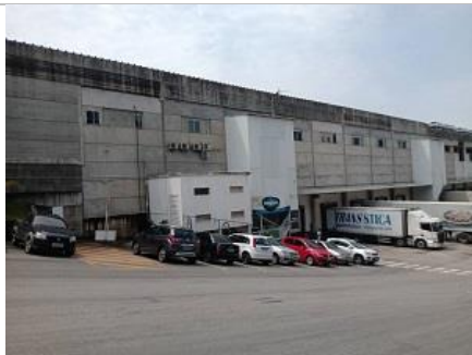
Fachada Frontal Galpão C
