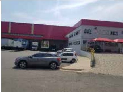
Vista externa do Bloco II
