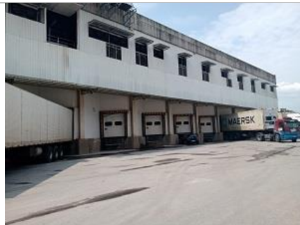
Fachada Galpões C6 e C7
