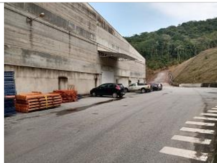
Fachada Lateral Galpão C
