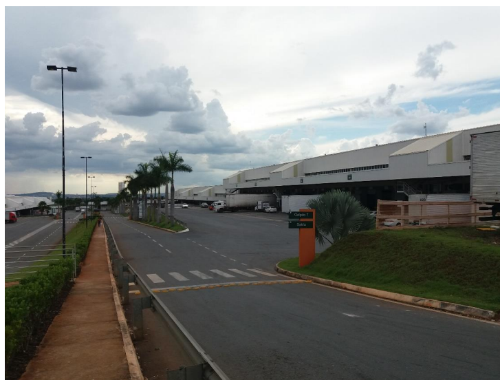
Vista geral do imóvel
