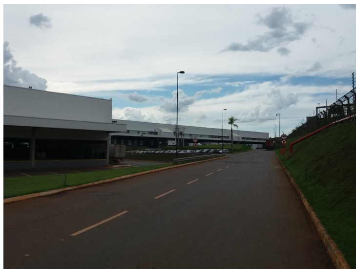
Vista geral do imóvel
