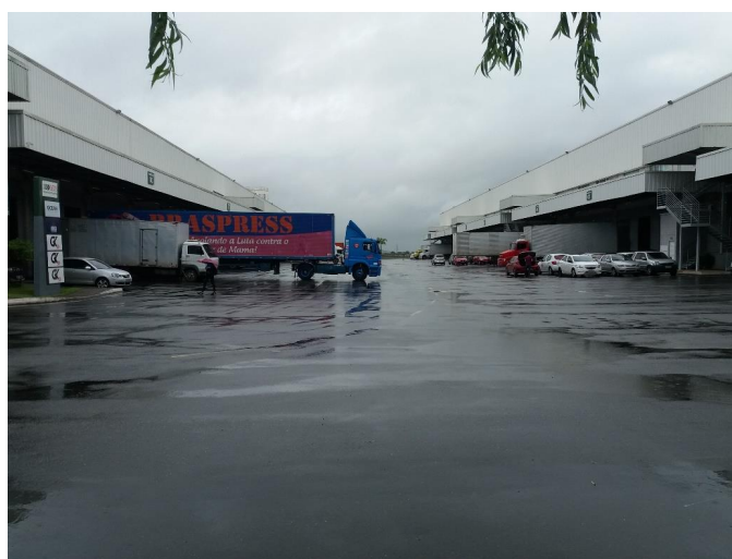
Área de manobra e docas do imóvel
