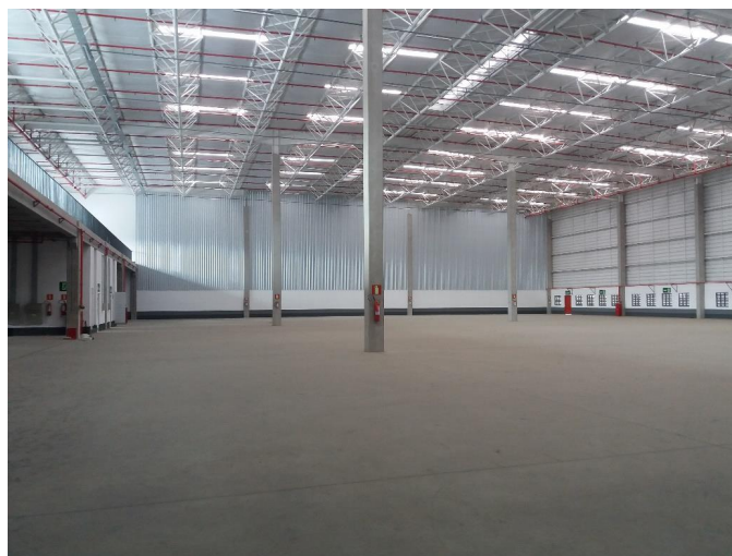
Área interna do galpão
