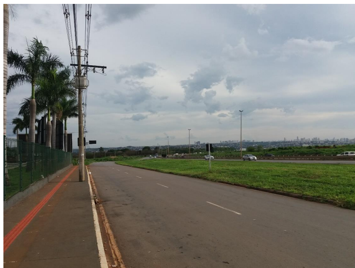
Rodovia BR-153, com o imóvel à esquerda
