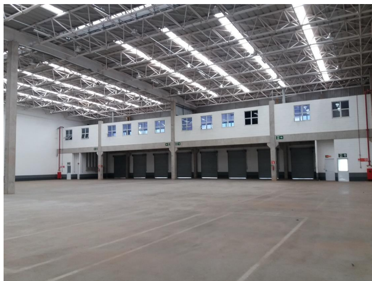
Vista interna do imóvel
