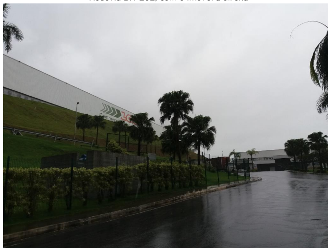
Rodovia BR-262, com o imóvel à esquerda
