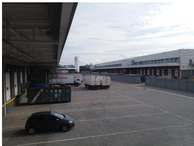
Área de galpão e marquise
