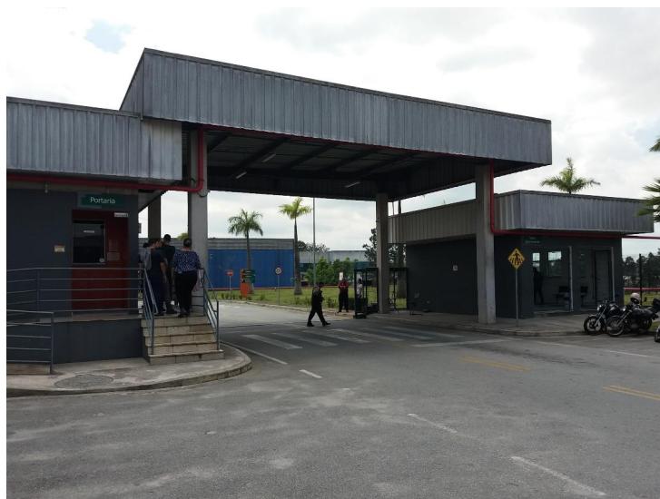
Portaria de acesso
