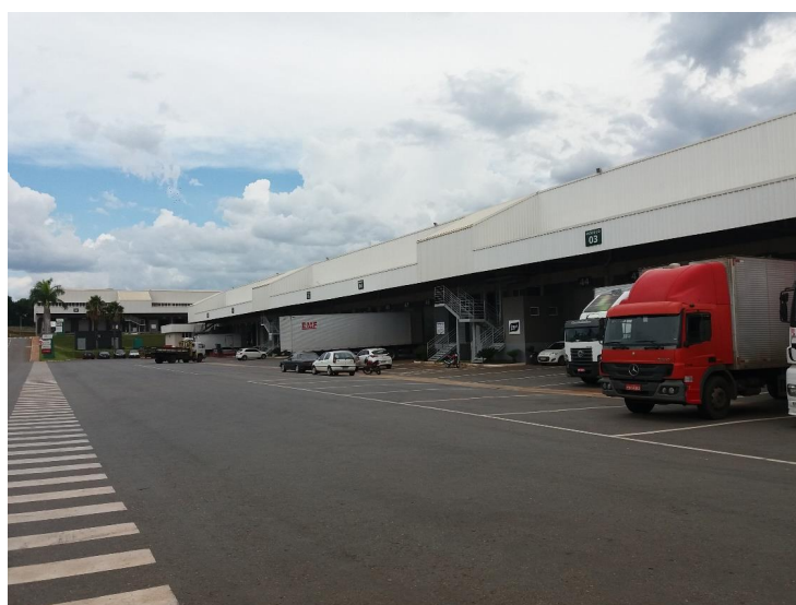
Vista geral do imóvel
