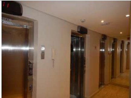
Hall de elevadores
