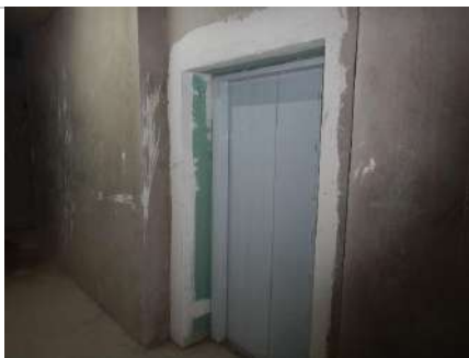
Hall e elevador de serviço
