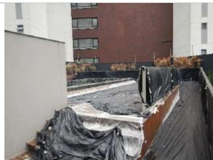
Piscina (em construção)
