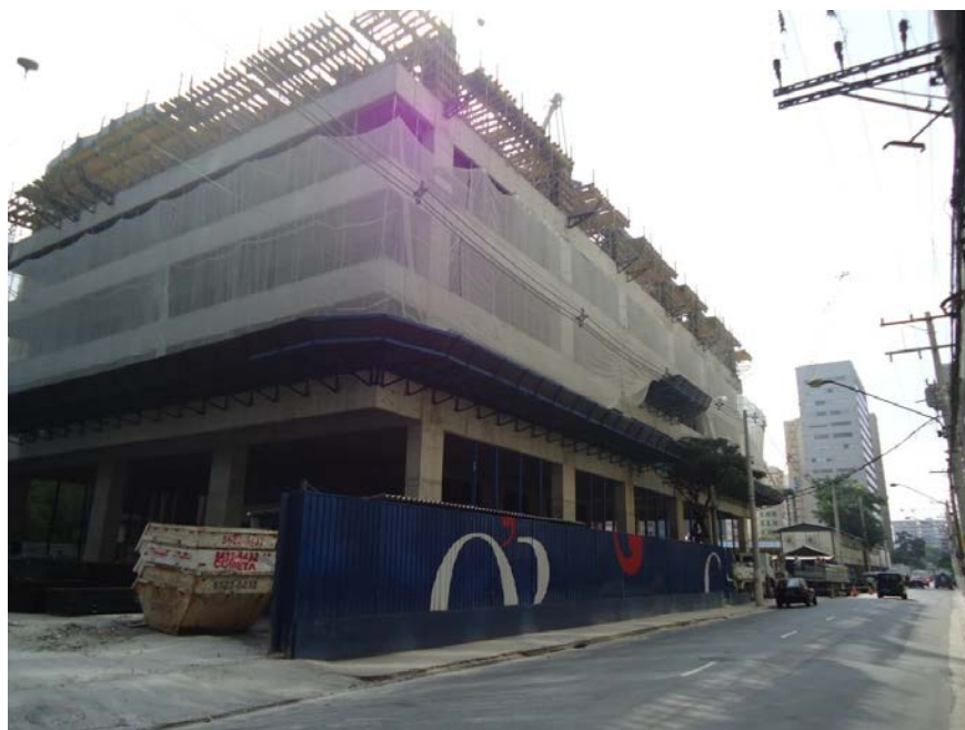
VISTA EXTERNA DO EDIFÍCIO EM CONSTRUÇÃO – TORRE A (PERMUTANTE) 18
