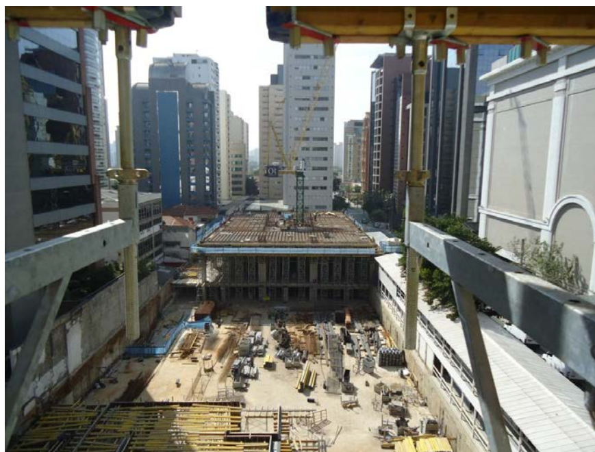
VISTA EXTERNA DO EDIFÍCIO EM CONSTRUÇÃO – TORRE B (ODEBRECHT) 18
