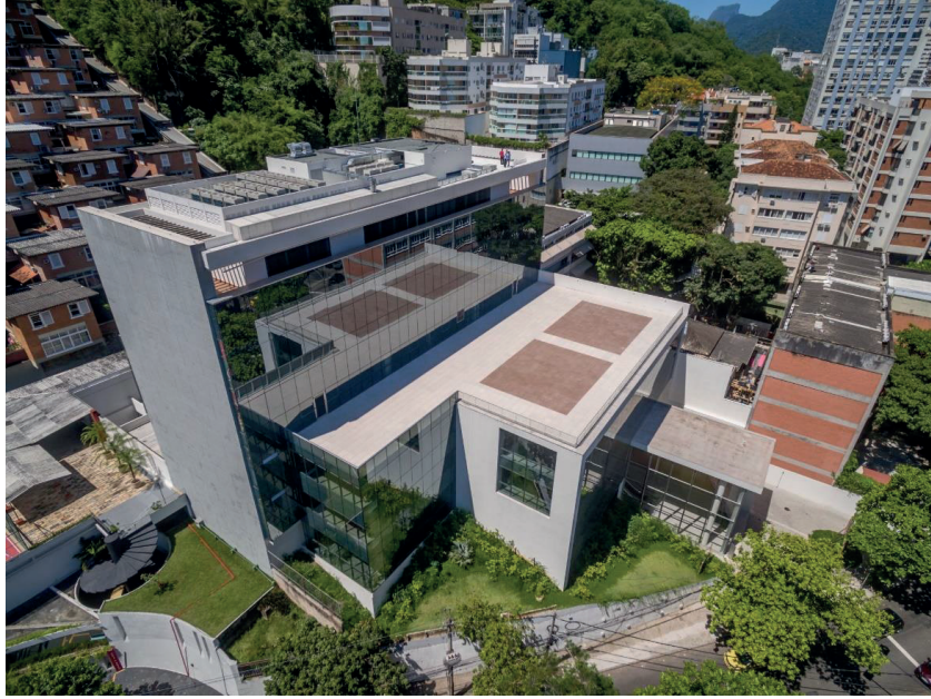
VISTA AÉREA DO EDIFÍCIO
