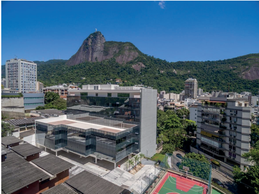
VISTA AÉREA DO EDIFÍCIO
