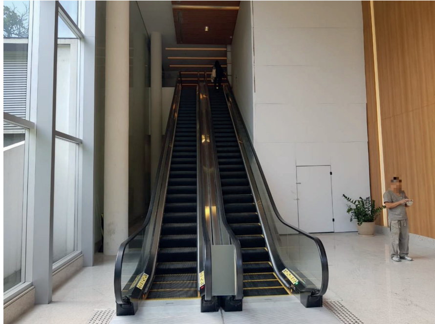
ESCADAS DE ACESSO À RECEPÇÃO
