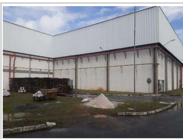
GALPÕES - VISTA EXTERNA
