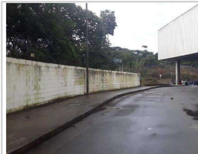
MUROS DE FECHAMENTOS DO TERRENO
