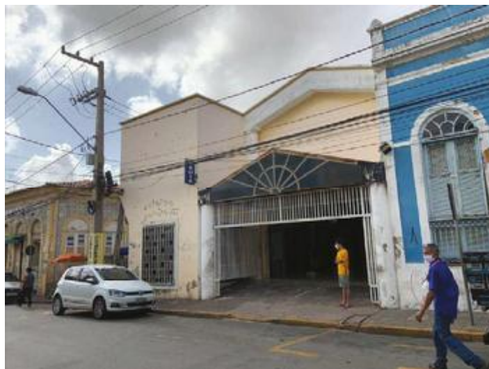
Vista externa do imóvel
