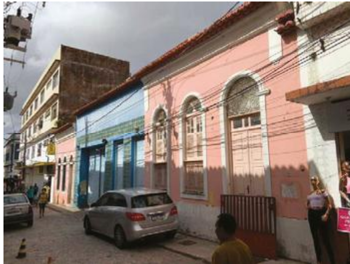
Visita externa do imóvel – imóvel a esquerda (Rua das Flores)
