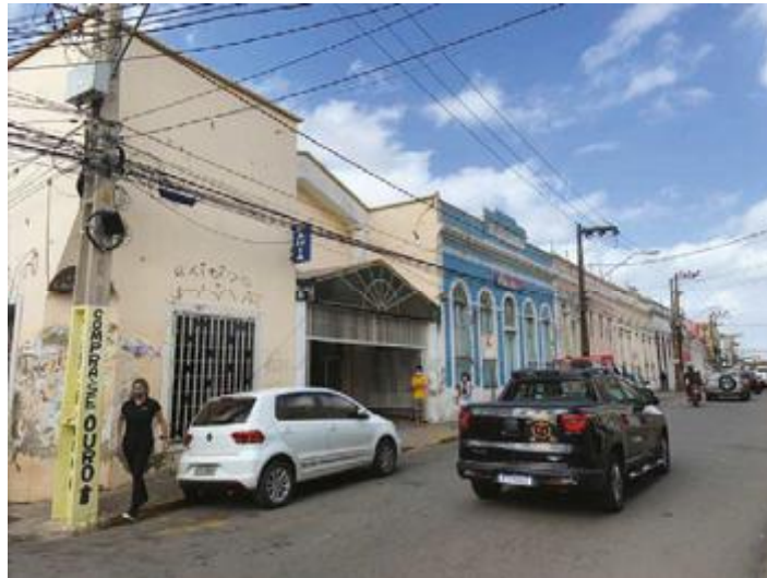
Vista externa do imóvel - imóvel à esquerda
