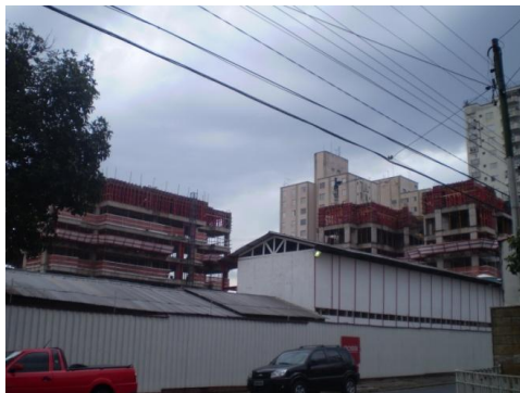
Vista frontal do canteiro de obras
