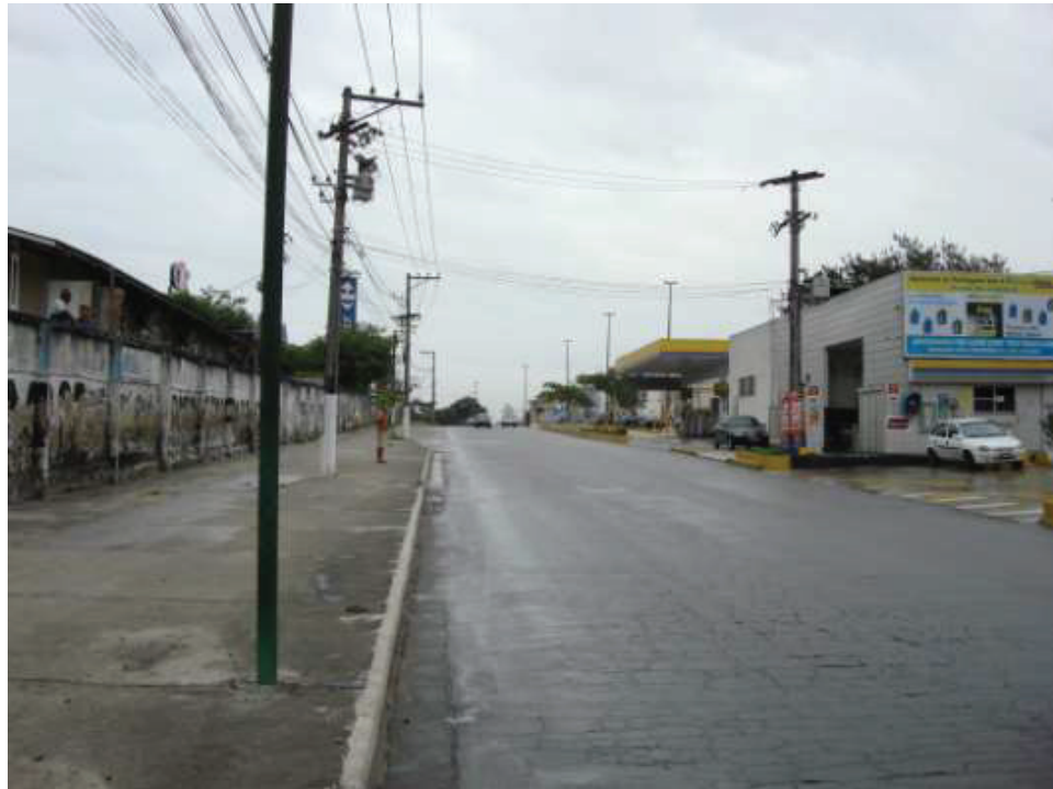
AVENIDA MARECHAL FONTENELE – À ESQUERDA DO IMÓVEL – VISTA 1
