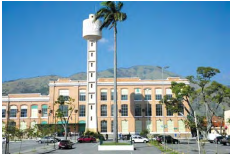
Fachada do Bangu Shopping, localizado na zona oeste do Rio de Janeiro. O shopping conta com 57,6 mil m 2 de ABL.
