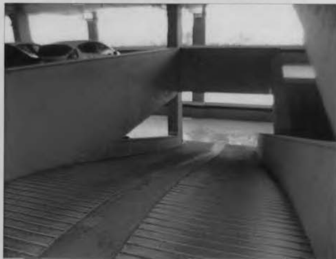
RAMPA DE ACESSO
