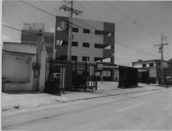
VISTA FRONTAL DO PRÉDIO GARAGEM
